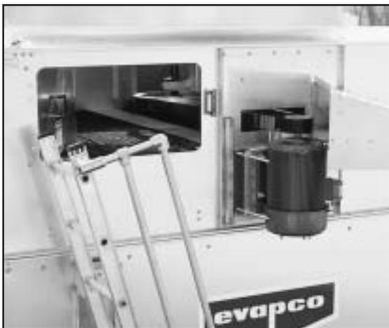
*Außen montierter Motor*
