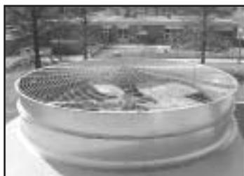
Der von EVAPCO angebotene “Low Sound“-Ventilator ist ebenfalls für geräuschsensible Anwendungen mit einer breiten Flügelgeometrie versehen. Die Flügel sind aus Aluminium gefertigt. Der von EVAPCO angebotene “Low Sound“-
